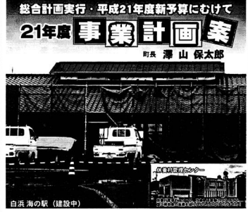
白浜海の駅（建設中）
